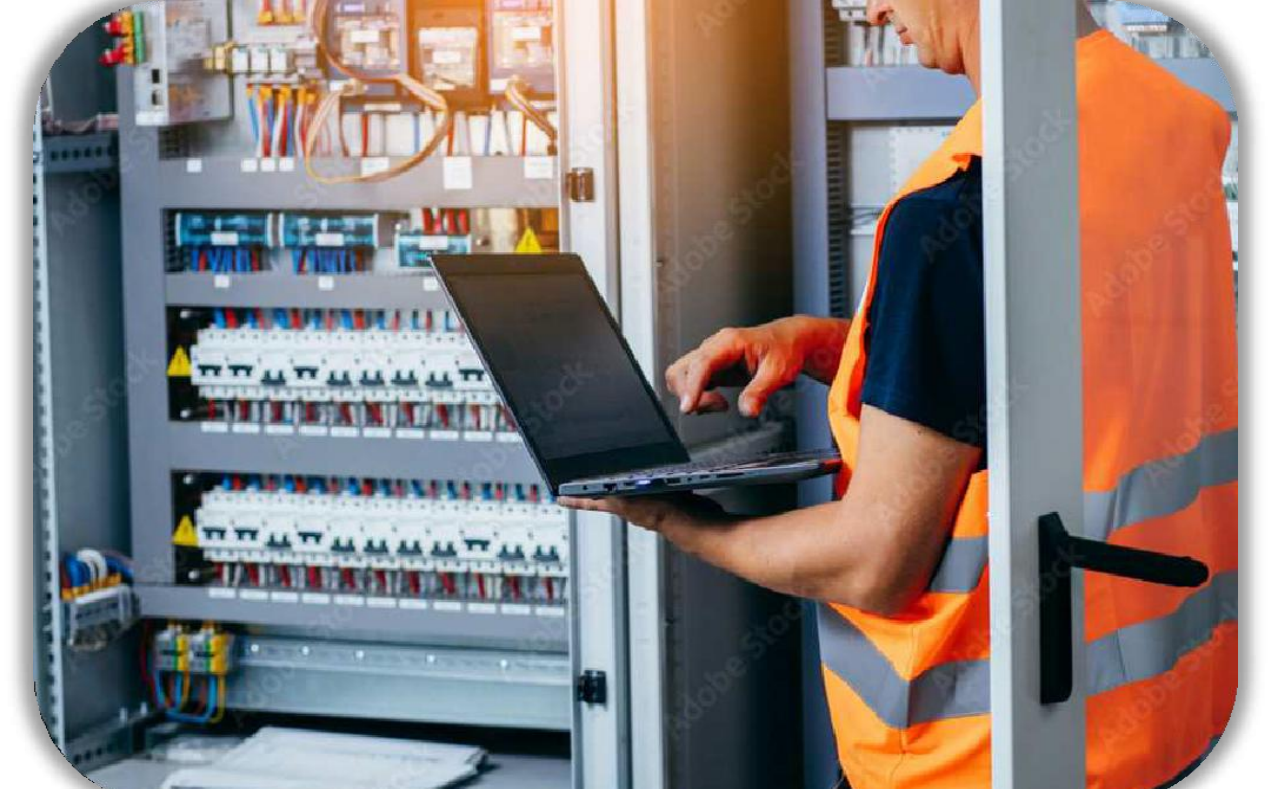
Mise en service
